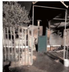
Il capannone incendiato
